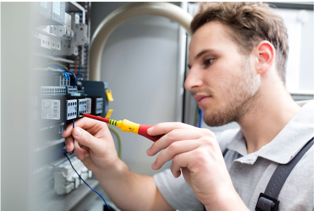
Abbildung 4: Arbeiten am Schaltschrank (Quelle: ZVEH)
