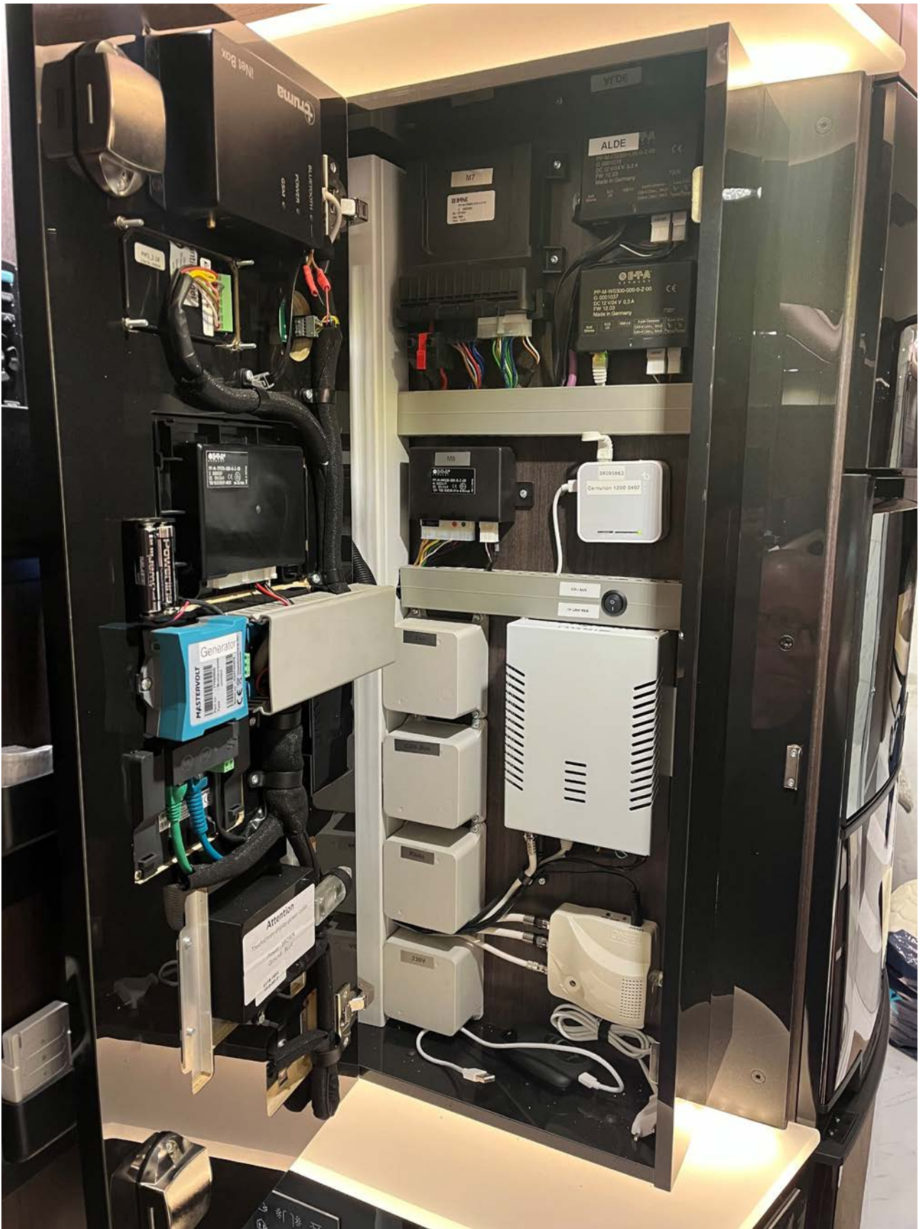
Abbildung 26: „Schaltzentrale“ eines Reisemobils (Quelle: ZKF)
