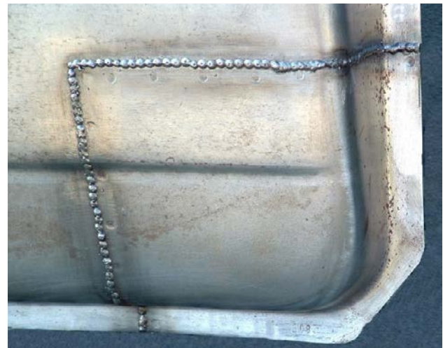
Abbildung 37: Mittels MAG-Steppnaht eingefügtes Blechteil (Quelle: ZKF)
